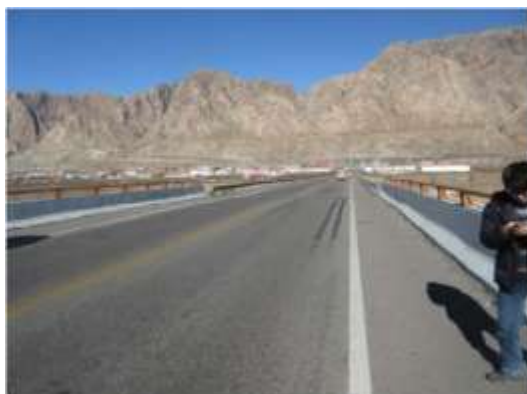
跨越处 215 省道现状
