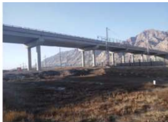
跨越处 215 省道现状
