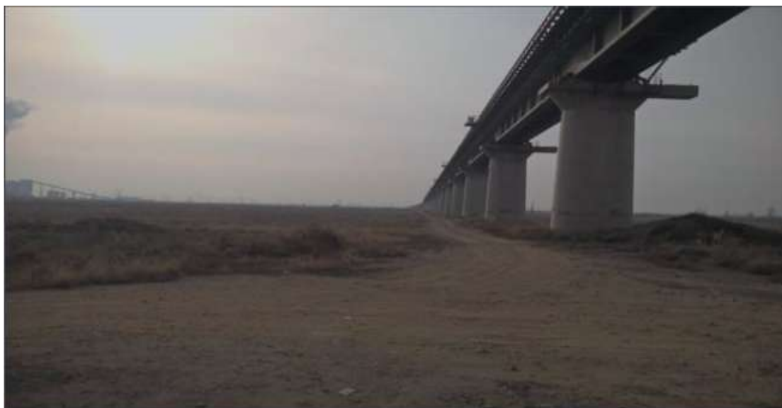
万甘铁路桥梁
