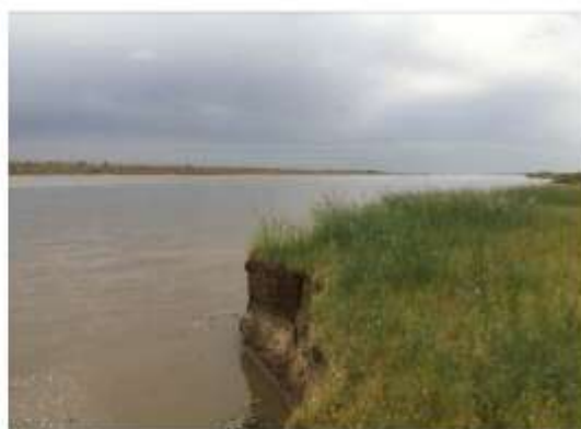
小里程侧现状主槽（面向下游）
