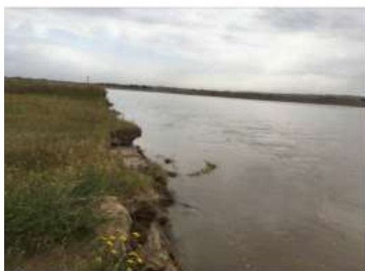
小里程侧现状主槽（面向上游）
