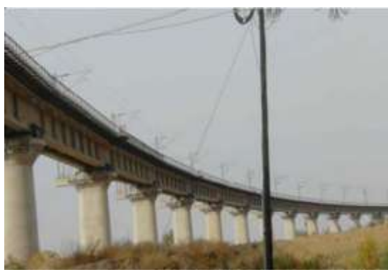
跨越处西甘铁路现状二
