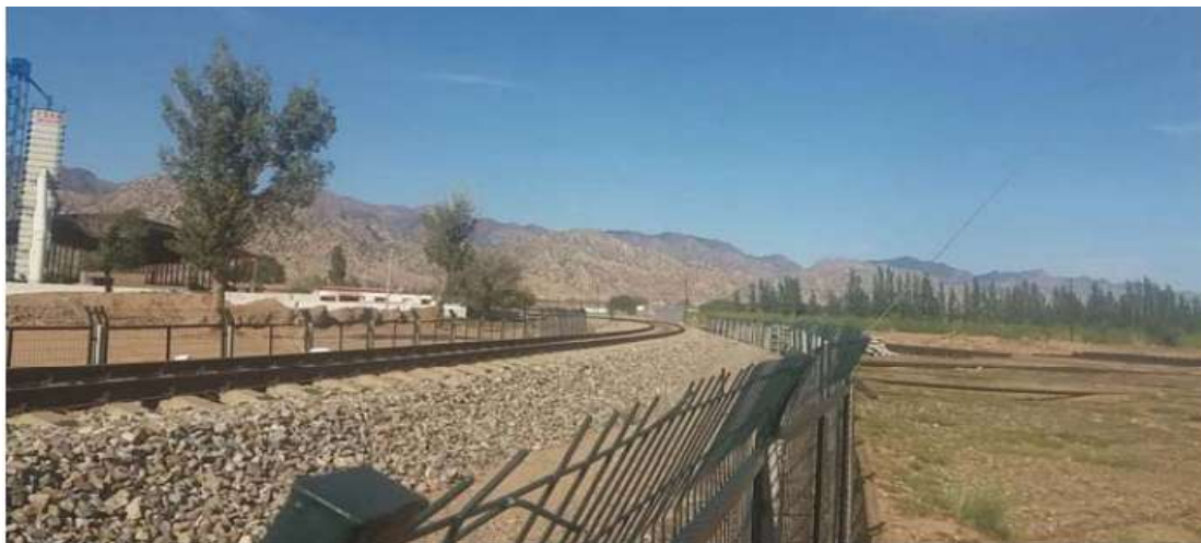
机场油库专用线
