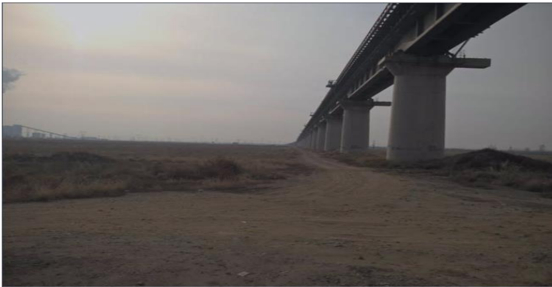
万甘铁路桥梁
