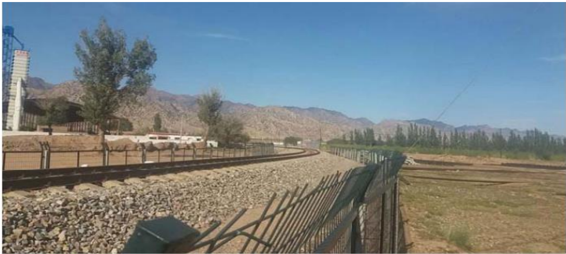
机场油库专用线
