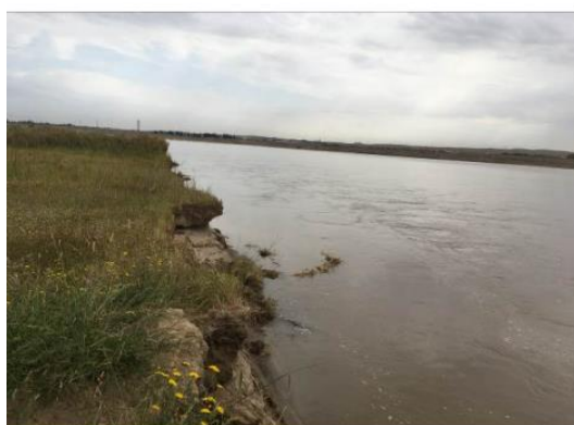
小里程侧现状主槽（面向上游）
