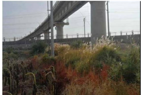
跨越处西甘铁路现状二
